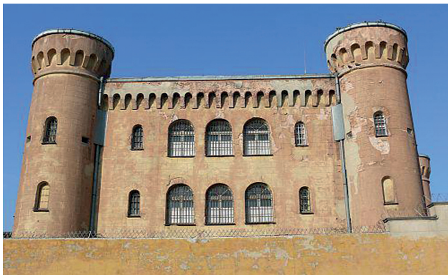
Zdjęcie nr 6. Charakterystyczna zamkowa bryła więzienia w Kaliszu.
